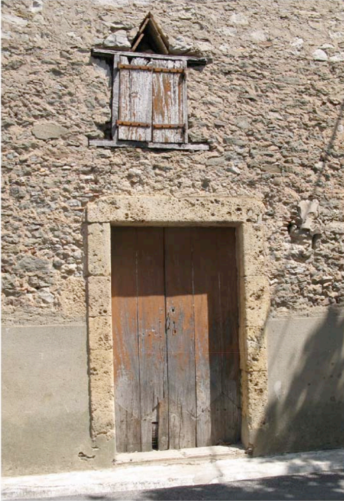
Comigne : composition de fenêtre et encadrement de bois pour une annexe . Arc de décharge en carreaux de terre cuite.
