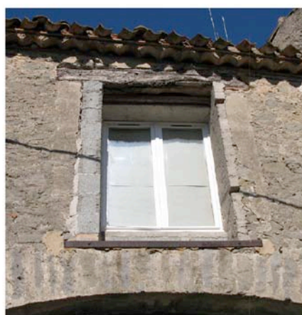
Marseillette reprise et modification d'ouverture et remplacement de menuiserie
