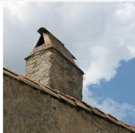
Villegailhenc forme de cheminée avec toiture en tuiles canal
