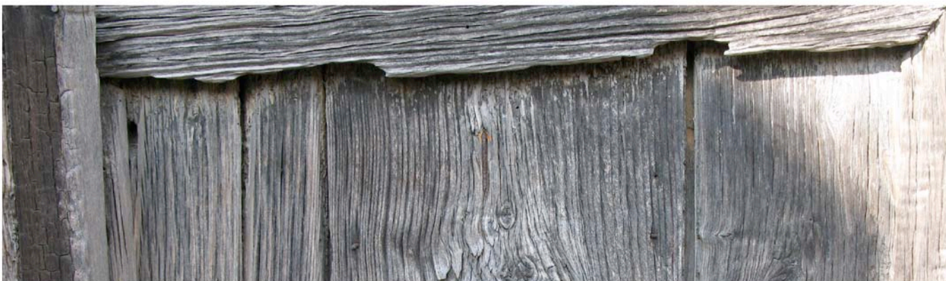
Fournes Cabardés : la menuiserie est en bois. Sans protection, le bois devient gris.
