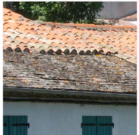
Lespinassière : le remplacement progressif des lauzes par des tuiles canal est courant, mariant couleurs et textures.
