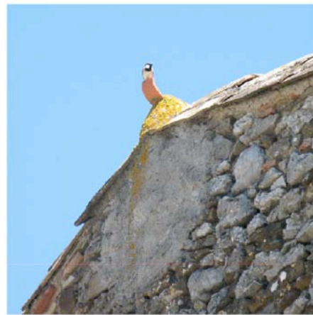
Monze détail au niveau des faitage de terre cuite
