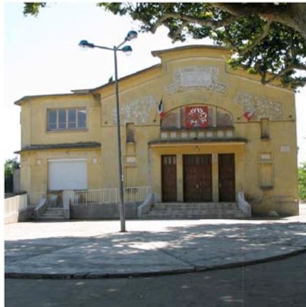
Peyriac Minervois : Foyer des Campagnes, une architecture et un programme qui s'inscrivent dans une pensée sociale et un mouvement moderne «classique» qui se développent localement au début du XX e siècle,
