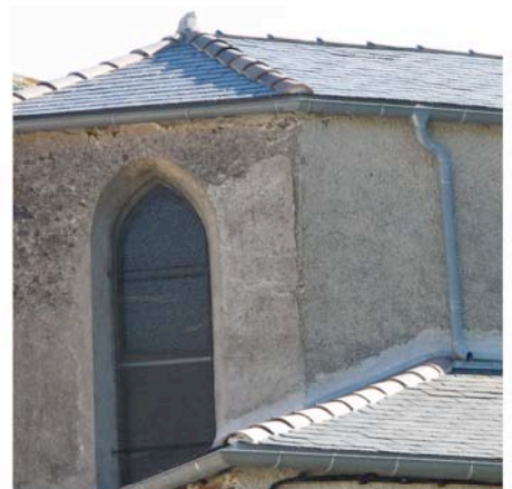
Roquefère couverture de l'église paroissiale
