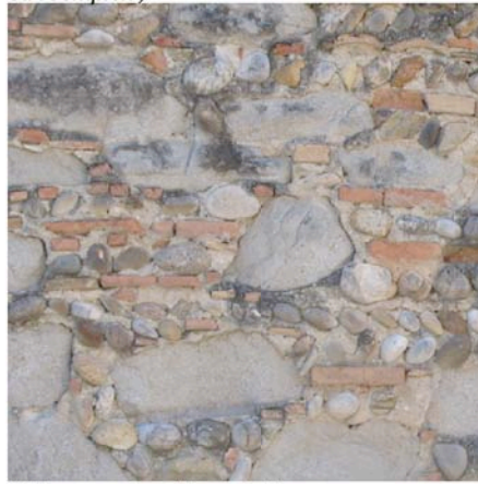
Villeneuve les Montréal exceptionnel assemblage de briques, galets pierre calcaire et terre
