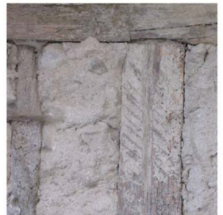
Villeneuve les Montréal : maison ossature bois , entre les colombages : remplissage en pisé (terre crue et fibres végétales).
