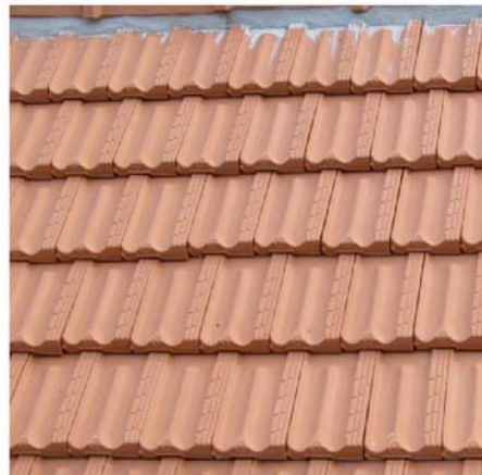
Miraval Cabardés , Le Rouger : mise en oeuvre de tuiles mécaniques récentes.
