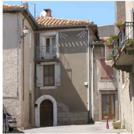
Caunes Minervois : si la maison témoigne de traces médiévales, elle a été «relookée» dans le courant du XIX e . Les décors et les enduits en témoignent encore
