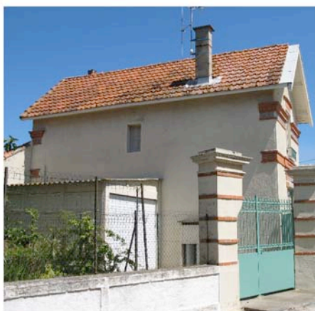
La Redorte, maison de l'entre deux guerres. La tuile de Marseille est cohérente avec cette architecture
