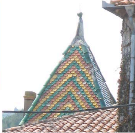
Capendu : relativement exceptionnel tuiles plates vernissées pour la couverture de cet élément d'architecture d'un domaine.
