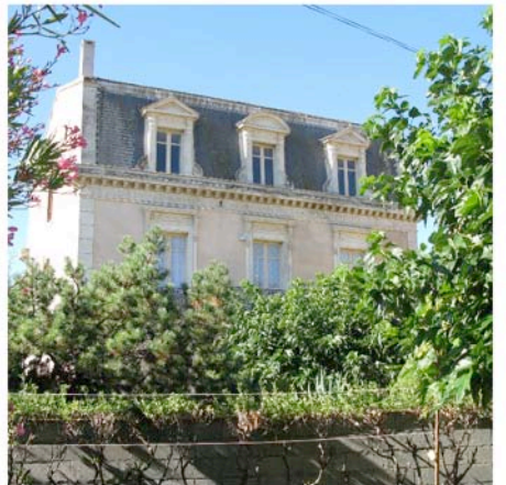
Marseillette :combles à la Mansard.
