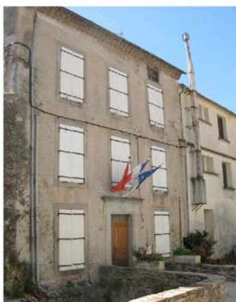
Cabrespine mairie, un bâtiment qui ressemble aux autres édifices du village avec une rigueur plus affirmée dans la composition
