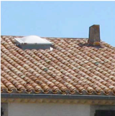
Peyriac Minervois création d'un skydome sur une toiture de tuiles canal
