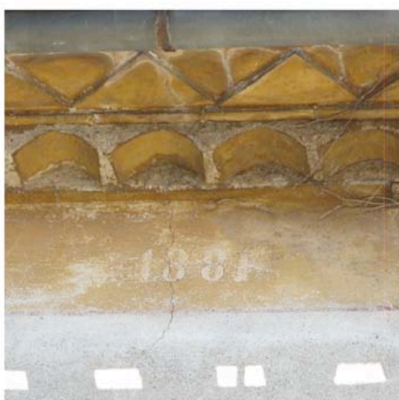
Azille : les badigeons de nombreuses façades portent les dates de leur réfection ici 1881. Les ocres sont d'origine locale.
