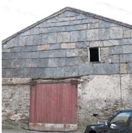
La Tourette: le bardage cet édifice situé sur la place entre dans la composition de la façade tout en protégeant du nord ouest.
