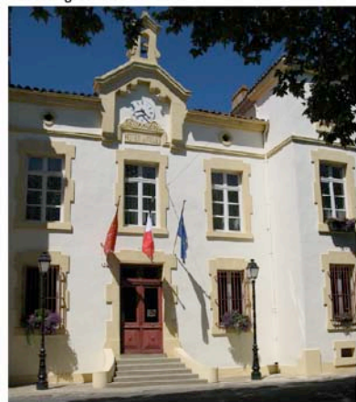
Azille, mairie, bâtiment correspondant à un modèle décliné sur de nombreuses autres communes à la toute fin du XIX e siècle,
