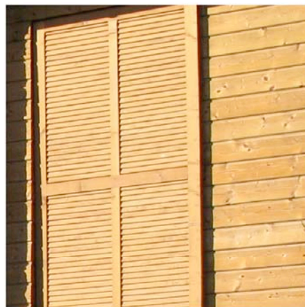
Ventenac : traitement des murs extérieurs et des menuiseries en bois pour ces logements contemporains
