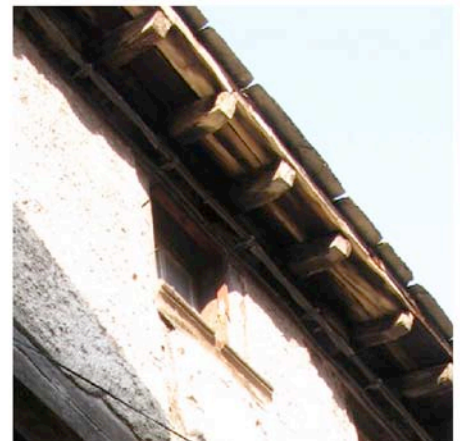
Mas Cabardés débord de toit (rare) en bois, ici lié à un édifice à structure bois.
