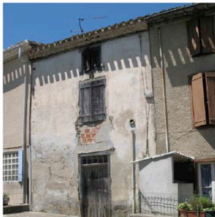
Alairac : trame étroite, habitat modeste, remise au rez de chaussée, pièce d'habitation à l'étage et grenier sous les combles
