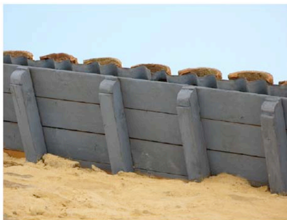
Peyriac Minervois débord de toit (rare) en bois mais la sous toiture rajoutée sous les tuiles canal est visible
