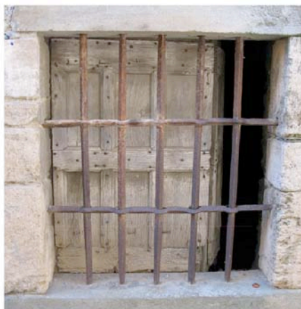
Les Ilhes Cabardès barreaudage et volet intérieur, fenêtre de demi-sous-sol.
