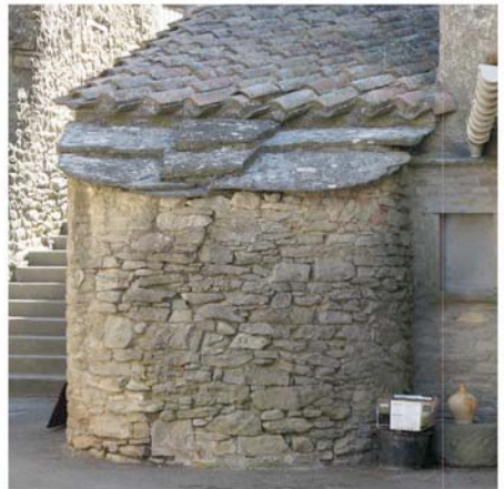
Villarzel couverture du four en lauze de pierre calcaire.
