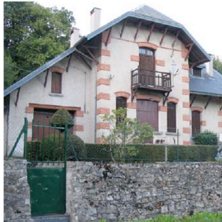
Lacombe , La Galaube L'architecture de cette villa de villégiature du début du XX e siècle peut être cohérente avec l'utilisation de l'ardoise régulière
