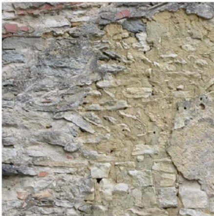
Moussoulens mur mitoyen faisant apparaître mélange de terre crue et de pierre calcaire
