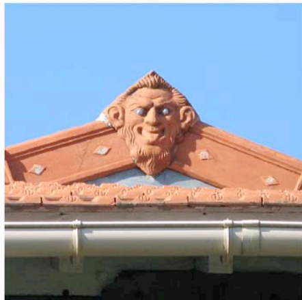
Les Martys : architecture de «pavillon» et décor de rive accompagnant la toiture de tuiles mécaniques
