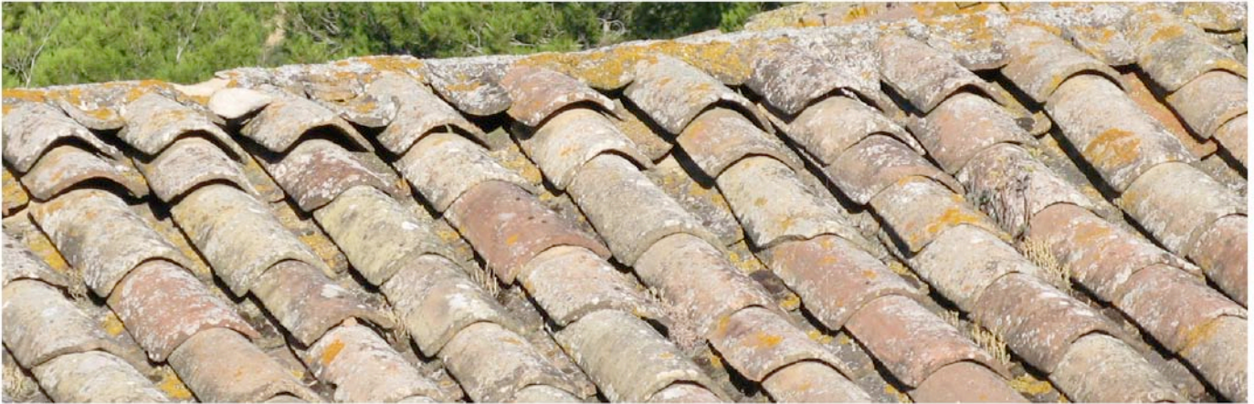
Bouilhonnac : le format des tuiles canal, leur pose, la charpente, permettent d'absorber dans le temps quelques déformations.
