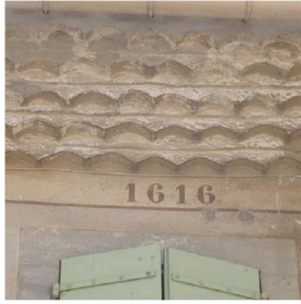
Douzens réendueite, mais exceptionnelle par le nombre de rangs, à noter le badigeon qui la couvre et le décor de couronnement avec date.
