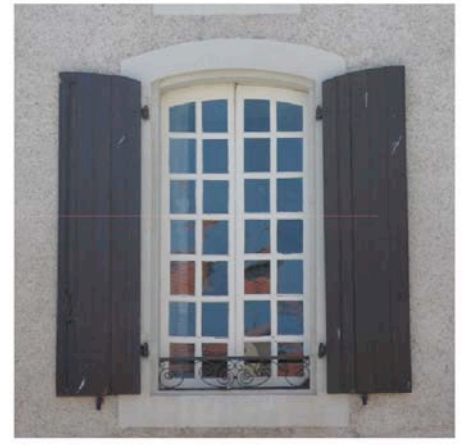
Arzens : fenêtre XVIII e à petits carreaux et à linteau courbe, encadrement de pierre.
