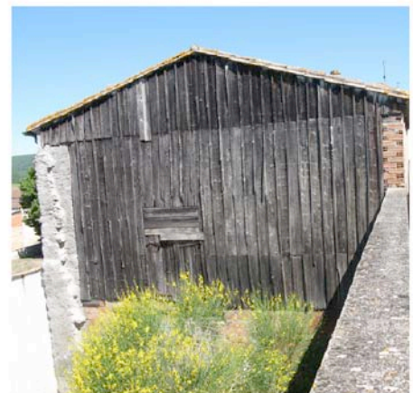
Montclar : le bardage de bois est rare en Pays Carcassonnais. Essentiellement utilisé pour les annexes et hangars. Ici il a grisé naturellement.
