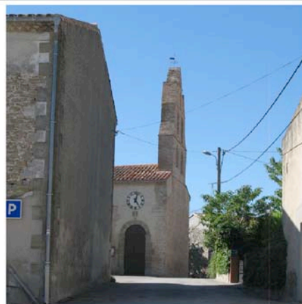
Villeneuve les Montréal : clocher mur de l'église
