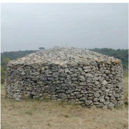
Montolieu : couverture de lauze de pierres calcaire pour les capitelles.
