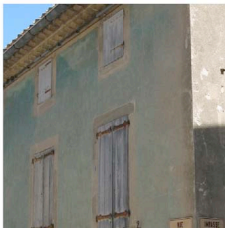
La Redorte : colorant vert pour le badigeon de la façade principale de cette maison.
