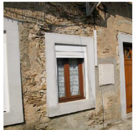
Fournes Cabardés : reprise ou création d'ouverture : encadrement, menuiseries, volets roulants.
