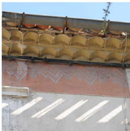
Bagnoles : décor peint (au pochoir?) dans le badigeon et modénature marquant un pilastre à gauche de l'image
