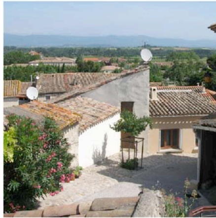
Capendu Depuis le belvédère au nord de l'église
