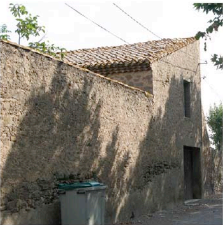
Azille, domaine de Jouarres : toit à 1 versant pour les annexes agricoles bâties autour d'une cour.
