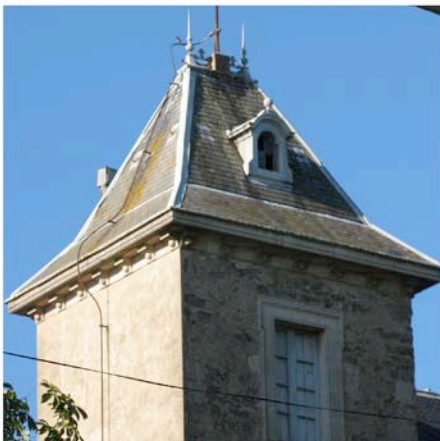
Blomac domaine, zinguerie, lucarnes accompagnent la mise en oeuvre de l'ardoise.
