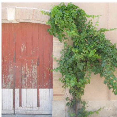
Azille : effet de soubassement, badigeon rosé sur enduit, répondent à la brique de l'encadrement, au rouge sang de la porte du chais.
