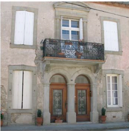
Saint Couat : reprise d'ouvertures en rez de chaussée et changements des menuiseries de portes et de fenêtres
