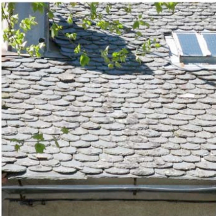
Saint Denis mise en oeuvre d'ardoises irrégulières en écaille de poisson
