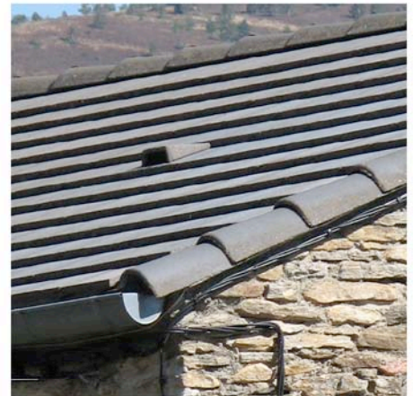
Castans hameau de Laviolle tuiles béton plates et noires
