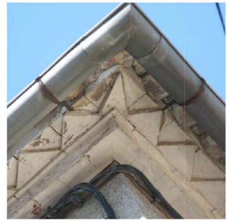
Rieux Minervois traitement d'angle urbain à base de carreaux de terre cuite, badigeonnée de chaux et formant décor de corniche.
