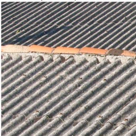
Labastide Esparbaïrenque tôle ondulée en fibro ciment sur constructions dans le village
