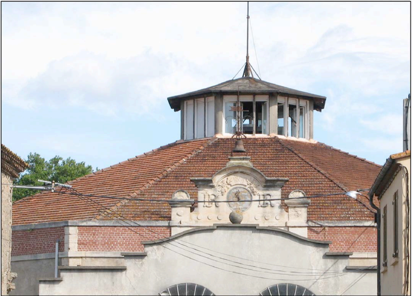
Azille : domaine de Jouarres la tuile mécanique plate dite de Marseille est cohérente avec l'architecture de cet édifice viticole.
