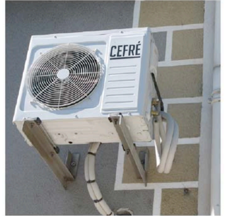
Puichéric : les apports d'équipements «bruts» en façade
