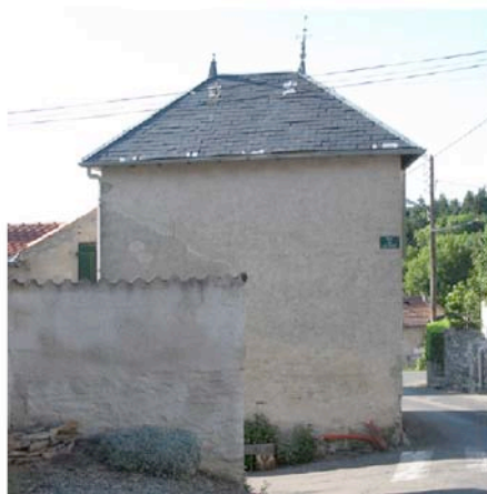
Les Martys petite villa de villégiature , toiture à quatre versants avec ses éléments de décor de couverture.
