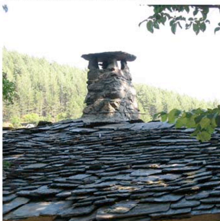
Castans : ferme des «lamas» couverture de lauze.
