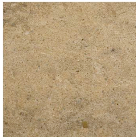
Villegly : les sables utilisés dans l'enduit le colorent.
