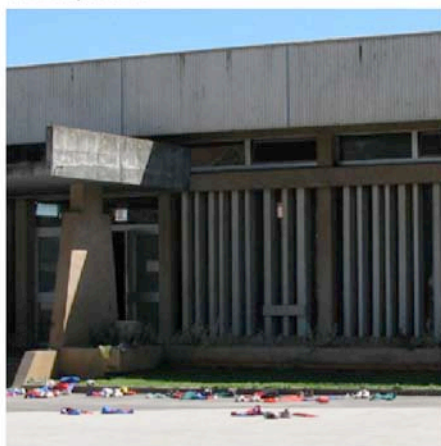
Pépieux : salle des sports et mise en oeuvre du béton, coffré, coulé, brut....
