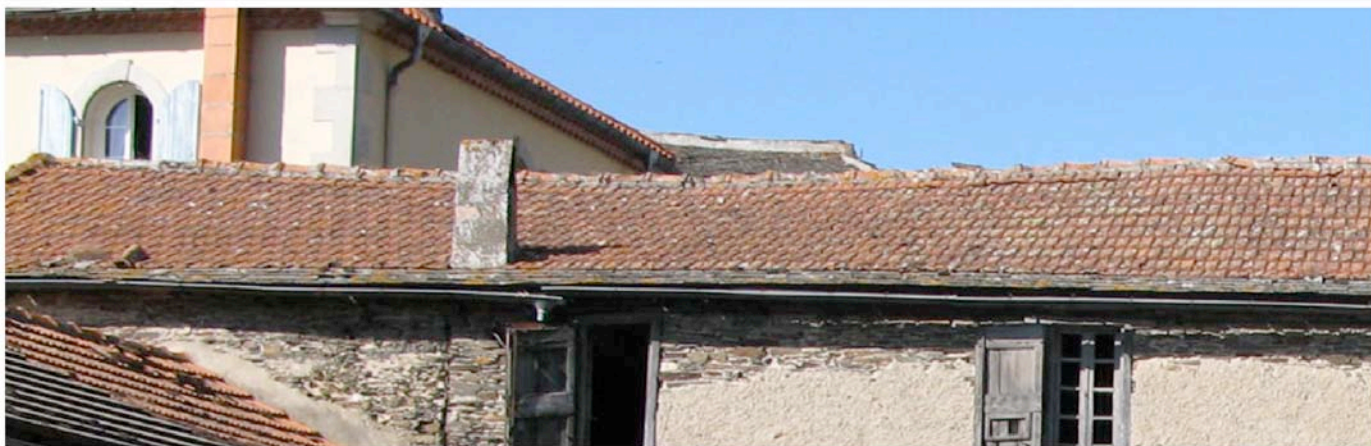
Caudebronde la tuile mécanique plate dite de Marseille s'adapte aux pentes des versants couverts de tuiles canal ou de lauze, qu'elle a pu remplacer.
