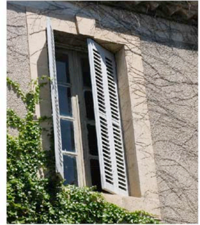
Saint Couat volet persienné repliable en tableau, encadrement pierre
