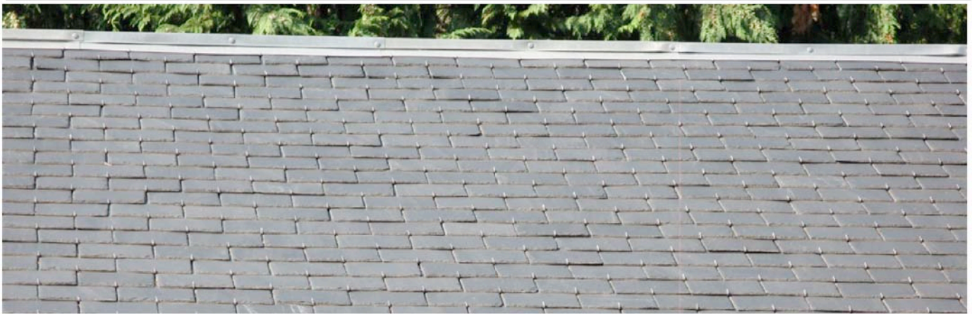
Cuxac Cabardés l'ardoise régulière posée au crochet, conduit ici à traiter le faitage de l'édifice avec de la zinguerie.
