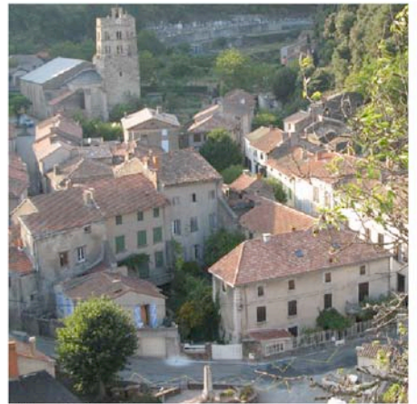
Mas Cabardés : une majorité de toitures à deux versants dans le barry, sur la départementale un édifice avec ses quatre versants tient compte de la situation urbaine.
