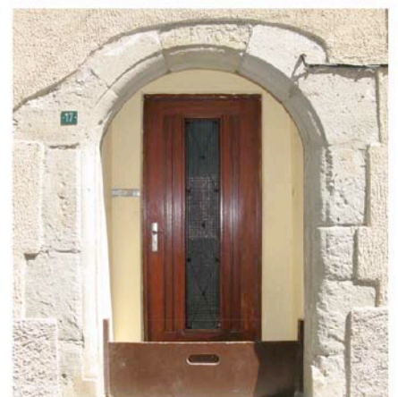
Rieux Minervois : mise en retrait et reconstitution d'ouverture de porte derrière cet encadrement daté du XVI e siècle.
