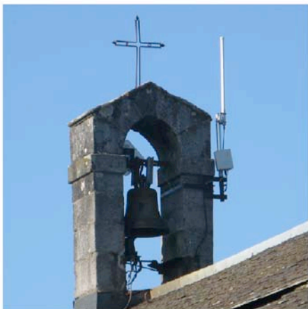
Laprade : installation d'antenne
