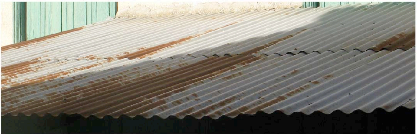
Labastide Esparbaïrenque couverture en tôle métallique d'un appentis
