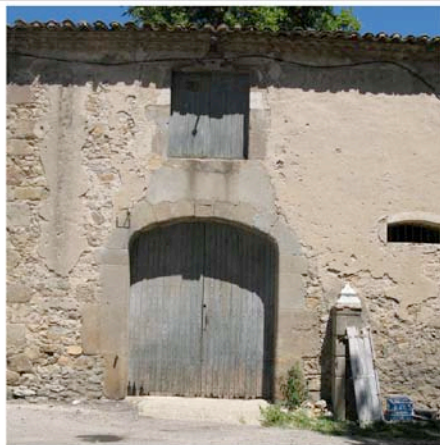
Saint Couat d'Aude : composition pour les ouvertures de ce chais, la porte épouse l'encadrement en anse de panier.
