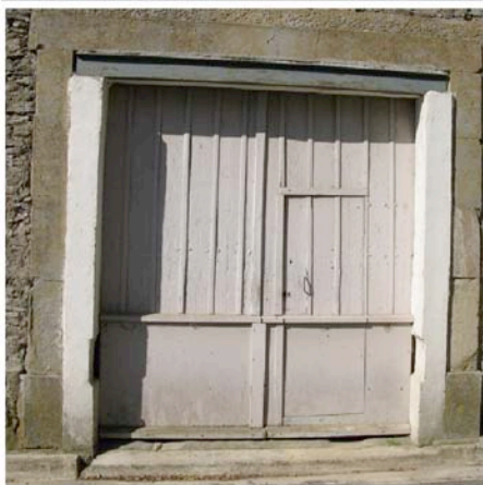
Bagnoles porte de chais à couvre joint
