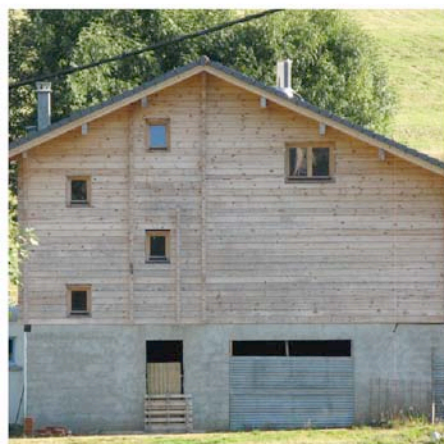
Laprade bardage de planches de bois horizontales pour cette maison en cours de chantier
