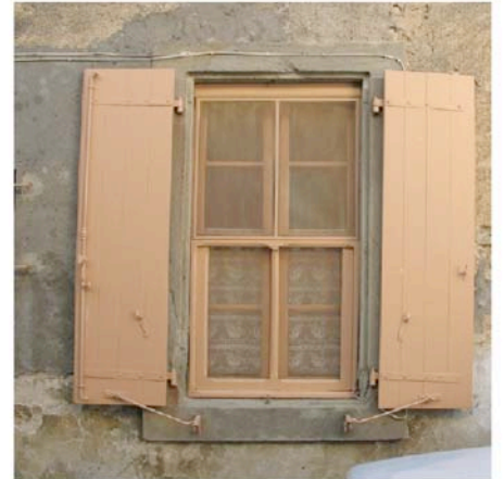
Malves : dispositif de moustiquaire adapté au fenêtre
