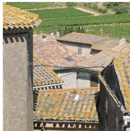
Villarzel : depuis l'escalier de la tour, imbrication des volumes de toiture..
