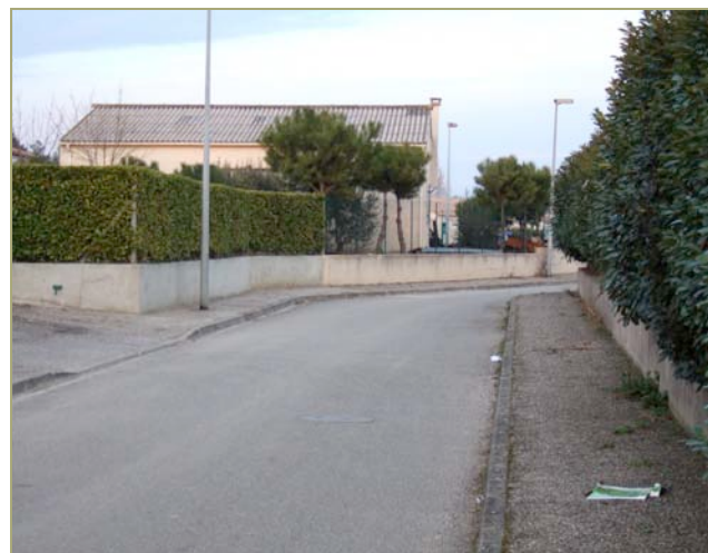
Les voiries internes de la Zone Artisanale
