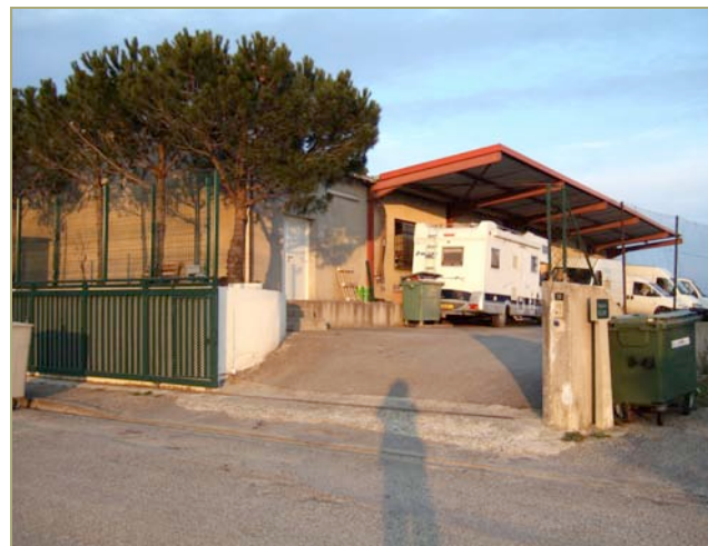
L'usine à pain
