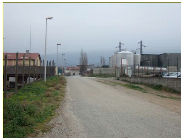
La voirie interne de la Zone d'Activités
