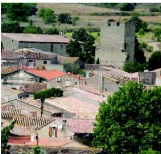
Laure Minervois, des toitures surgit la tour d'une des portes d'entrée
