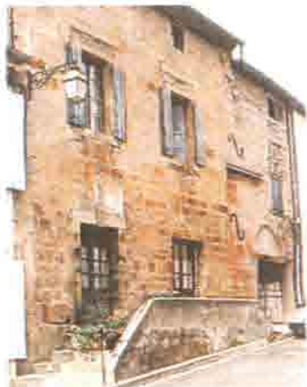
< Maison médiévale à ARQUES (en cours de restauration)
