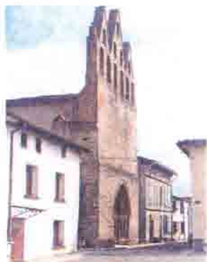
< Carillon à MOLANDIER (en cours de restauration)
