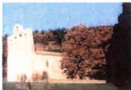
Chapelle Sainte Cécile à RIVEL > (en cours de restauration)
