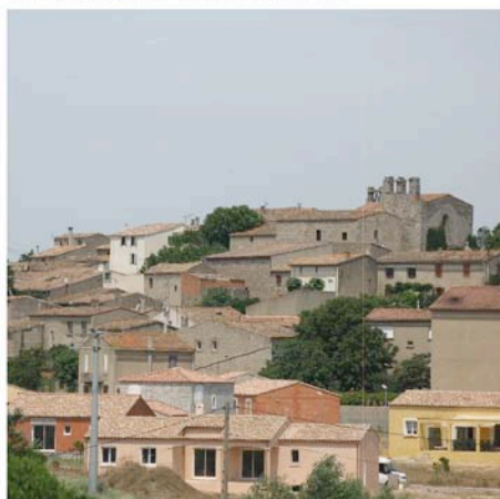
Comigne le fort et en dessous étage
