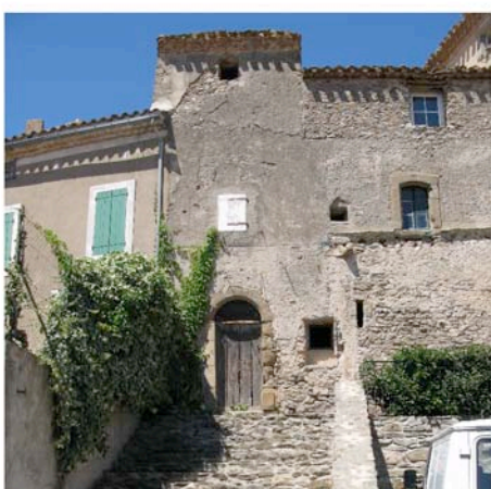
Saint Couat, le fort. Aujourd'hui un ensemble d'édifices mitoyens dans une forme circulaire
