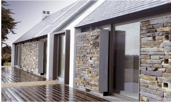
Maison à Belle-Ile en Mer – Opus 5 architectes Bruno Decaris / Agnès Pontremoli - panneaux « paravents » en schiste
