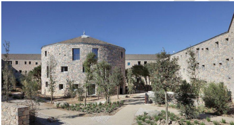
Pierre sèche en parement d'immeubles et murets d'accompagnement du bâti. Ametis – Rudi Ricciotti 2014
